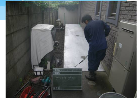
プライマー塗付 (1度塗り)
