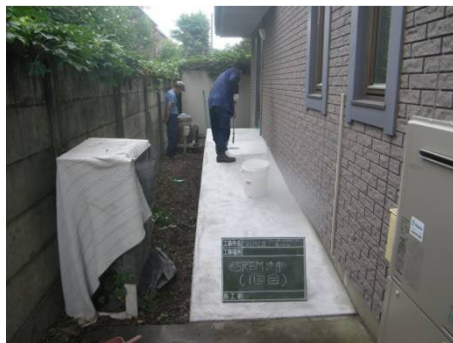
SREM塗付(2度塗り) 「デザイン」の場合には 必要に応じて塗り重ねます。
